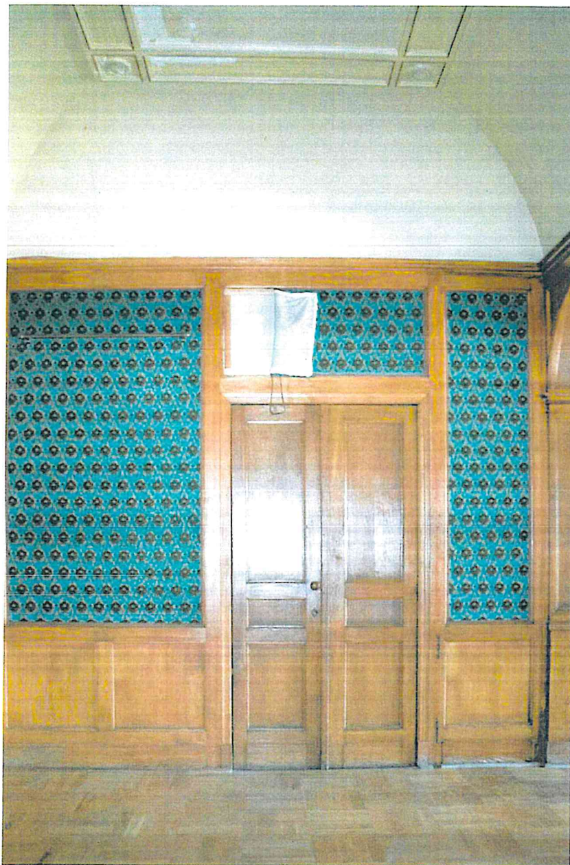
Fot. 8 Drzwi w części korytarzowej. Ściana północna.
