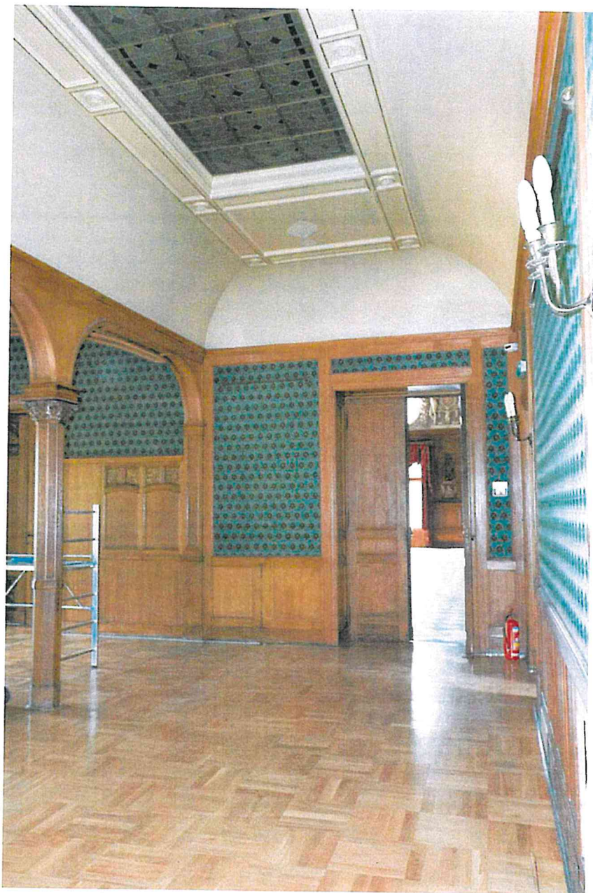
Fot. 1 Część korytarzowa. Widok na stronę południową.
