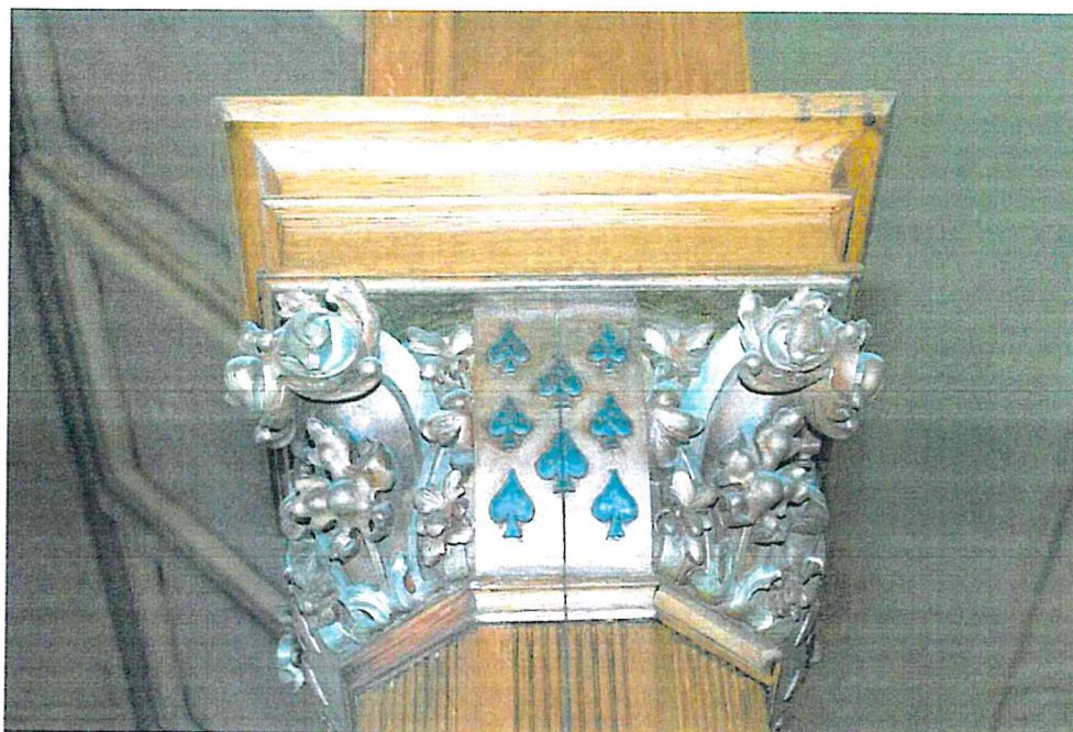
Fot. 5 Kapitel kolumny północnej. Widoczne spękania.
