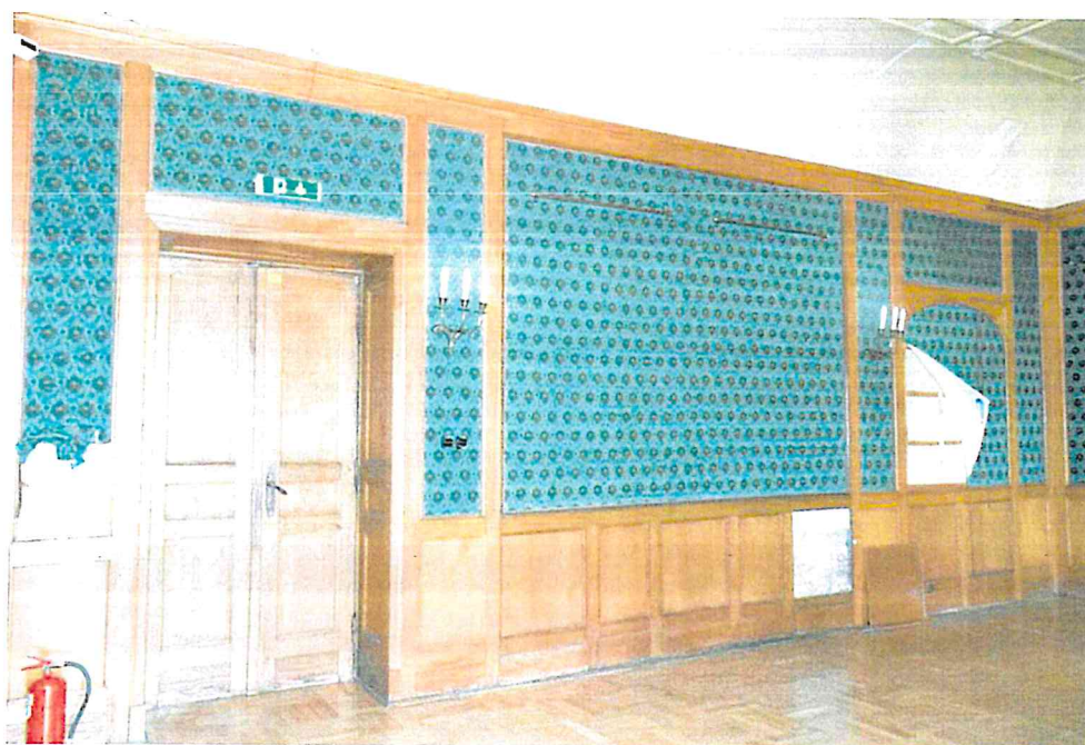
Fot. 3 Część korytarzowa. Ściana zachodnia.
