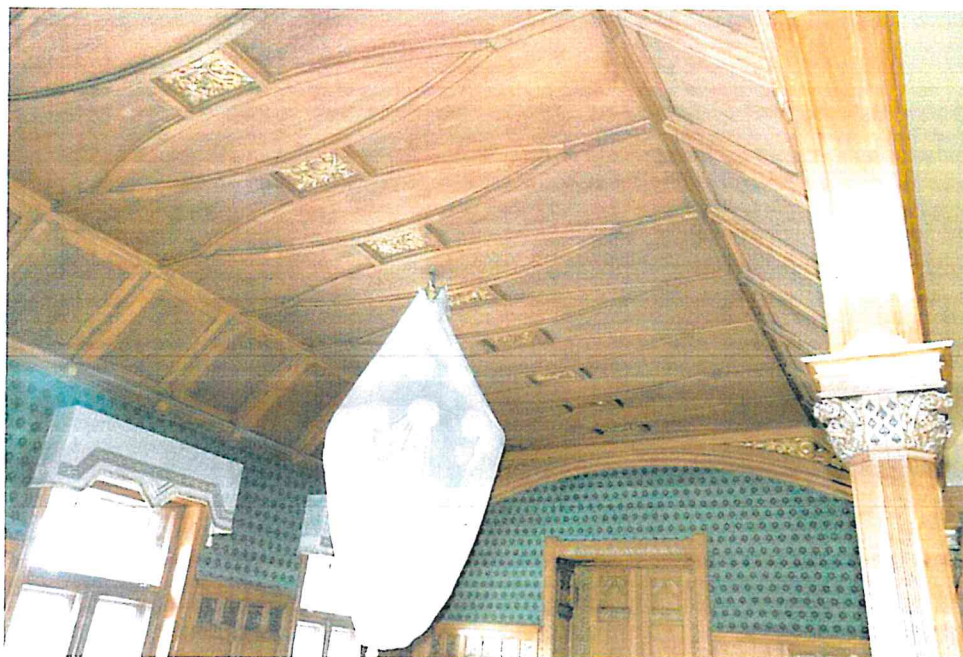
Fot. 17 Sufit w głównej części sali. Widok na stronę południową.
